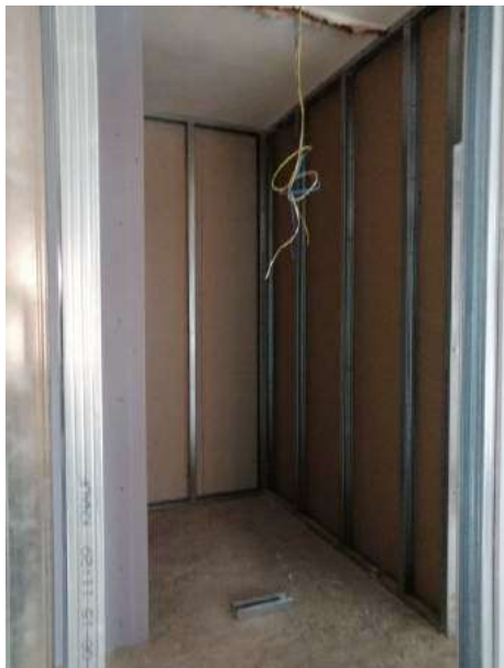
Foto 14 – Locale ricavato sub 528
