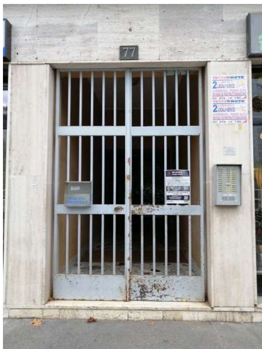
Foto 4 – Ingresso al fabbricato
